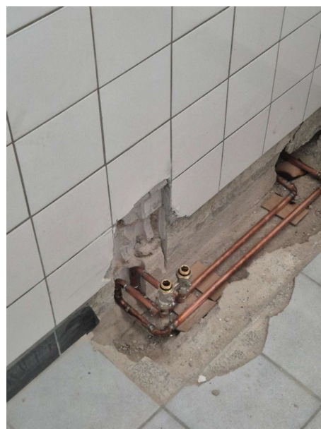
Anpassung Heizung im WC
