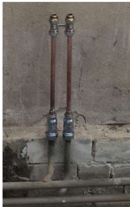
Anpassung Heizung im DLRG-Raum
